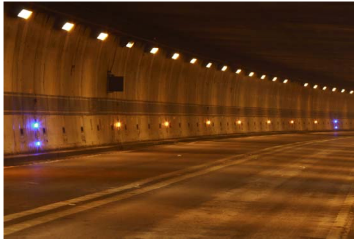
Interno della galleria Frejus
