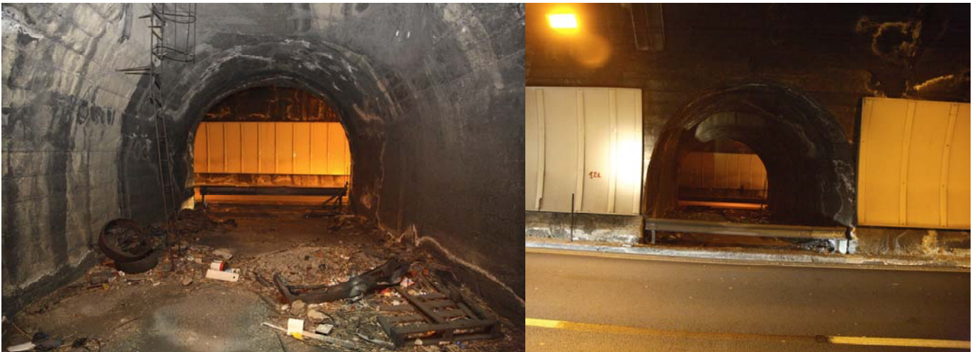
Interno ed esterno del by-pass di collegamento tra le due canne
