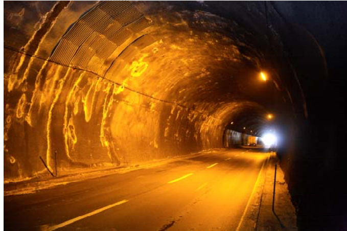
Interno della galleria Pacì 2
