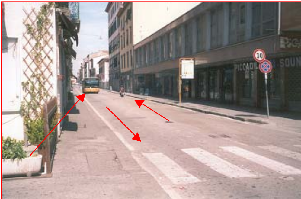
Fig. 3. - Esempio di inadeguatezza spaziale in una via del centro storico di Livorno
